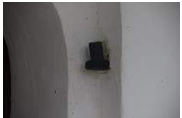
Металлические элементы дверных проемов.
