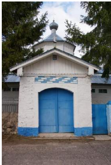
Вход на паперть. Западный фасад.
